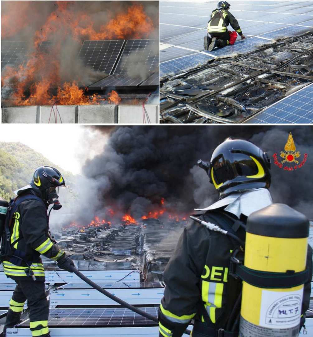
Fig. 13 – Esempi di incendi di pannelli fotovoltaici
