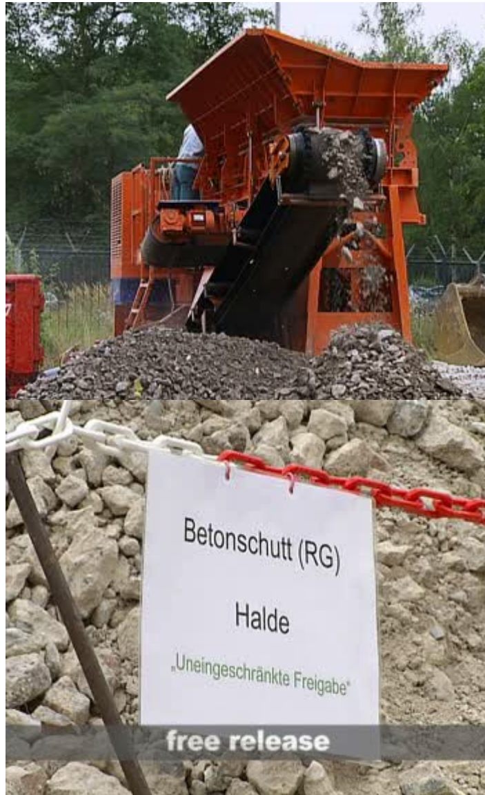
Fig.11 - Riduzione in pezzi del calcestruzzo del contenimento, con successiva analisi e responso dell'Ente di Controllo: “libero rilascio” (fonte: “The Kahl nuclear power test plant – Dismantling the reactor building”, NUKEM GmbH)
