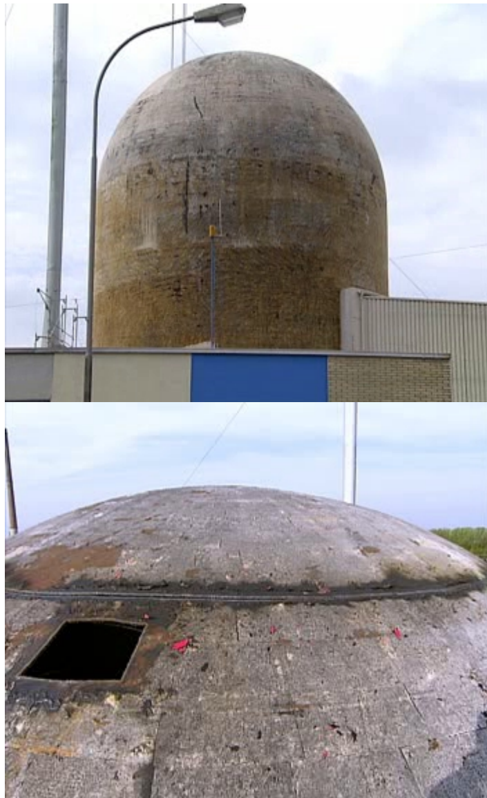
Fig.14 - Liner di acciaio rimanente dopo la rimozione del contenitore esterno di calcestruzzo (fonte: “The Kahl nuclear power test plant – Dismantling the reactor building”, NUKEM GmbH)
