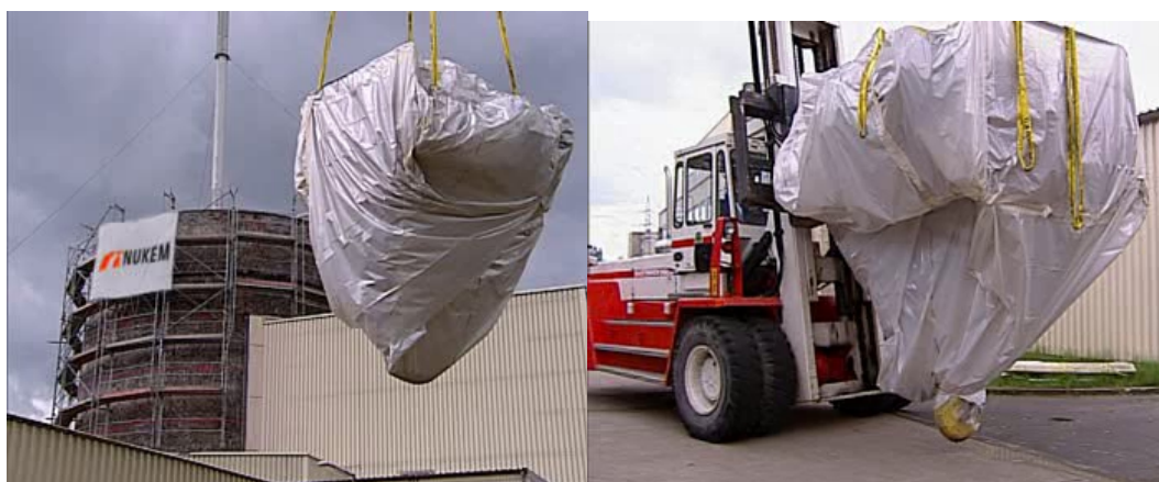
Fig.16 - Rimozione del montacarichi, previa preventivo impaccettamento (fonte: “The Kahl nuclear power test plant – Dismantling the reactor building”, NUKEM GmbH)
