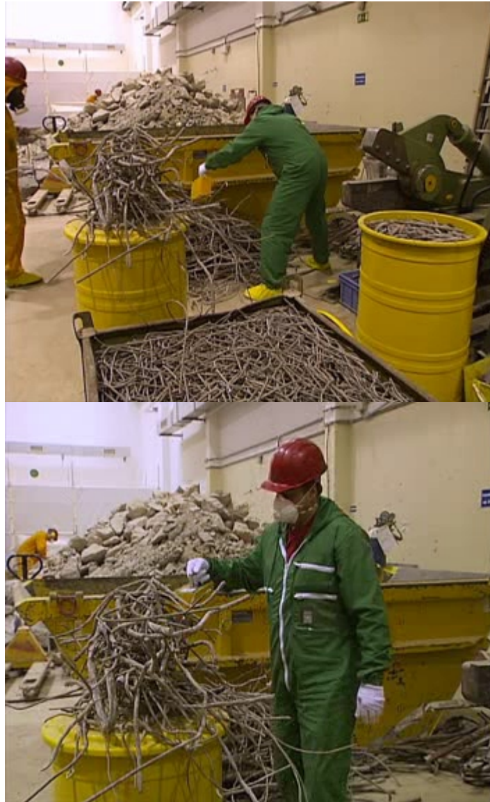
Fig.12– Recupero dell'acciaio nelle operazioni di smantellamento del sito per applicazioni convenzionali, previa preventiva verifica con rivelatori gamma (fonte: “ The Kahl nuclear power test plant – Dismantling the reactor building ”, NUKEM GmbH)
