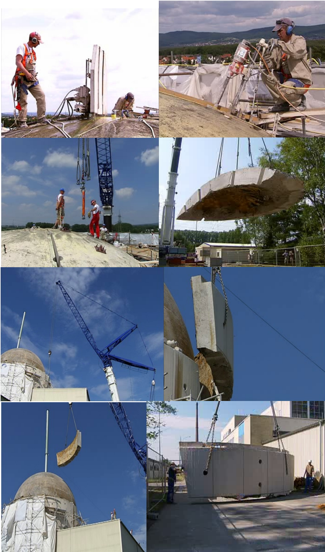
Fig.10 - Operazioni di taglio e rimozione del guscio esterno di calcestruzzo del contenimento (fonte: "The Kahl nuclear power test plant – Dismantling the reactor building", NUKEM GmbH)
