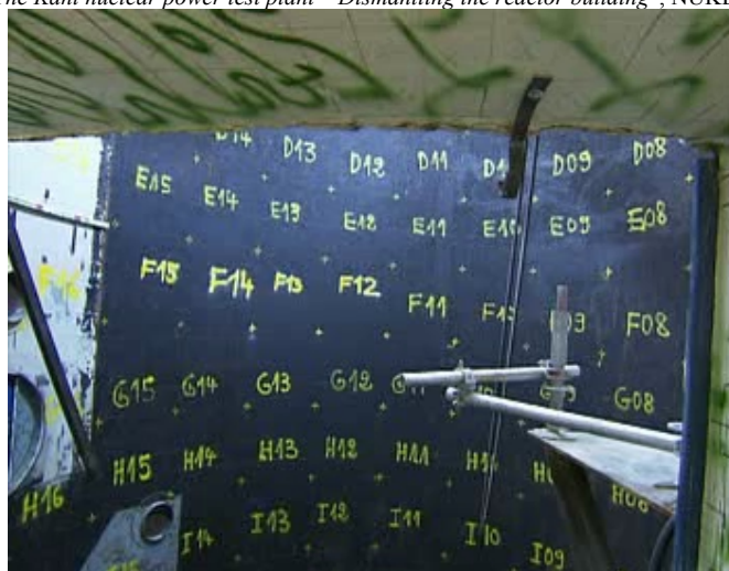
Fig.7 – Mappatura dettagliata del contenitore interno di sicurezza (fonte: “The Kahl nuclear power test plant – Dismantling the reactor building”, NUKEM GmbH)
